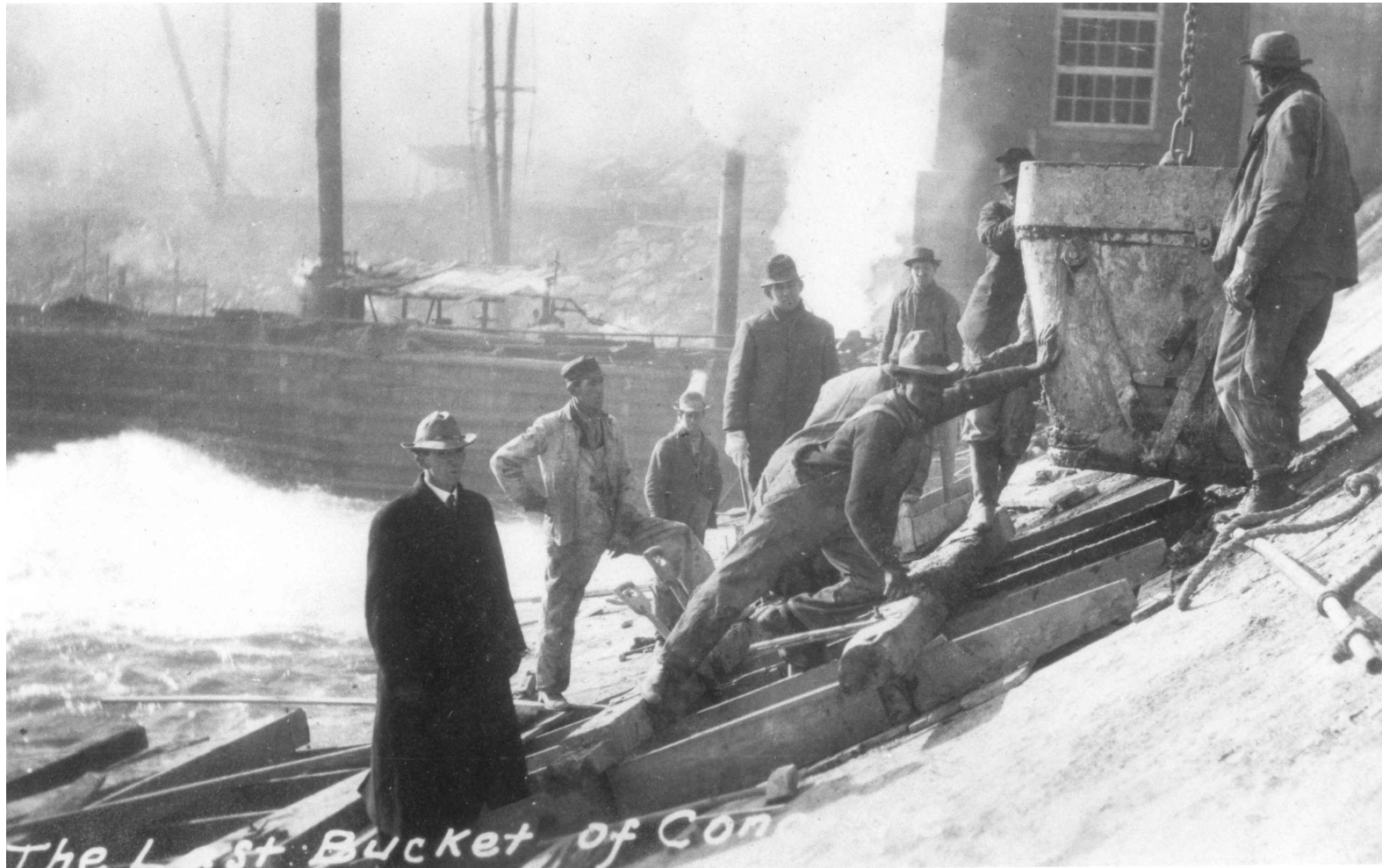
Figure 169. Last Concrete Pour
